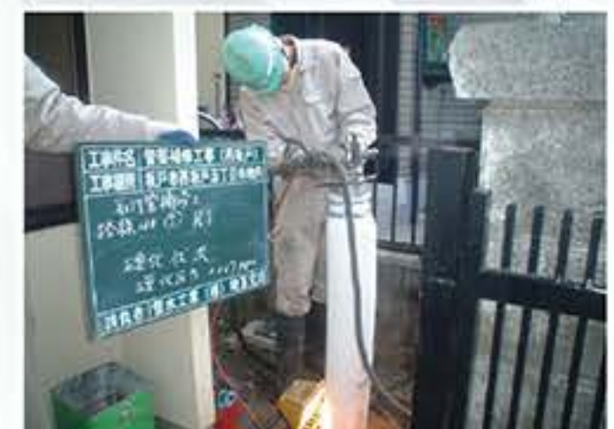
取付管更生材硬化状況
