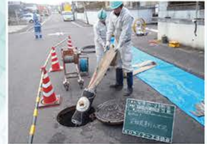
取付管反転装置引込状況
