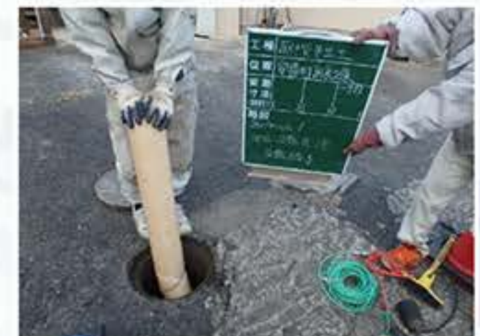
取付管更生材反転状況
