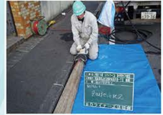
取付管更生材装着状況
