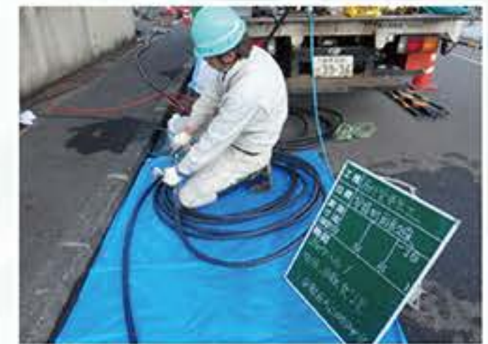
反転装置エア注入状況
