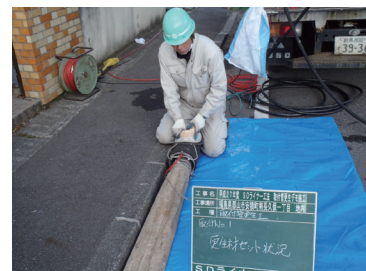
取付管更生材装着状況
