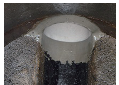
管口仕上げ状況
