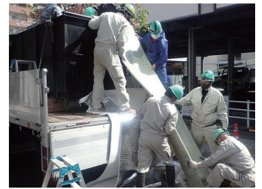
材料挿入状況
