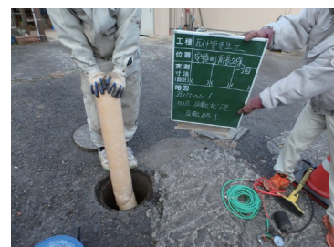
取付管更生材反転状況
