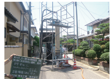
更生材硬化状況
