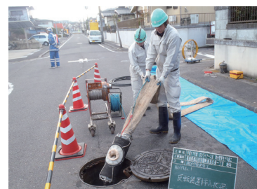
取付管反転装置引込状況
