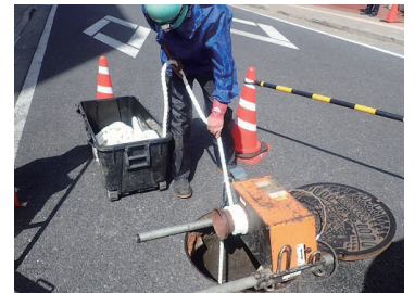
電動ウインチ巻上げ状況
