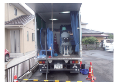
穿孔ロボット操作状況
