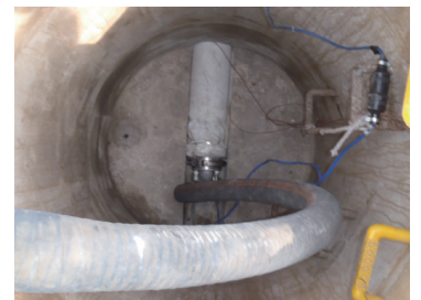
拡張・硬化状況
