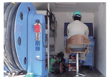
穿孔ロボット操作状況
