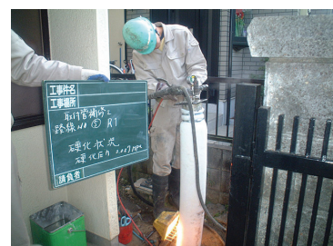
取付管更生材硬化状況
