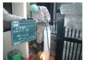
取付管更生材硬化状況
