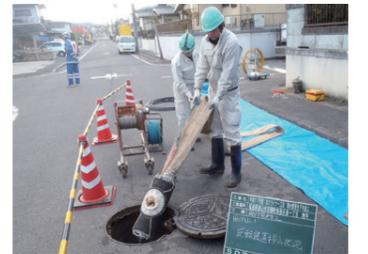
取付管反転装置引込状況
