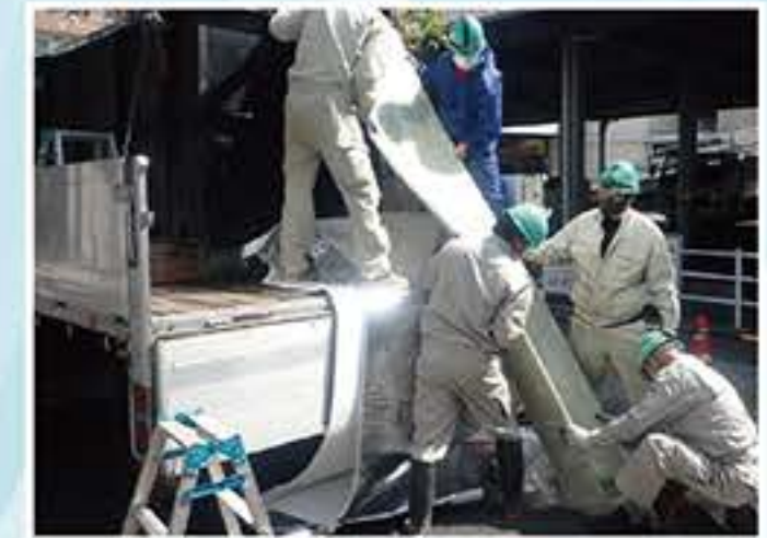
材料挿入状況
