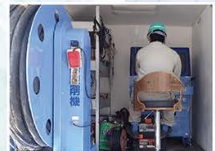
穿孔ロボット操作状況
