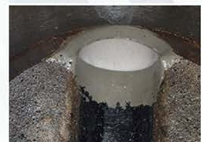
管口仕上げ状況
