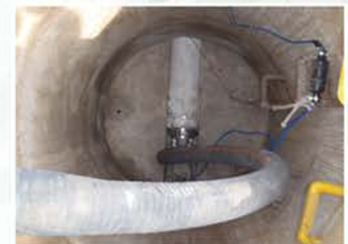
拡径・硬化状況
