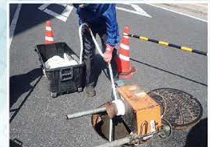
電動ウインチ巻上げ状況
