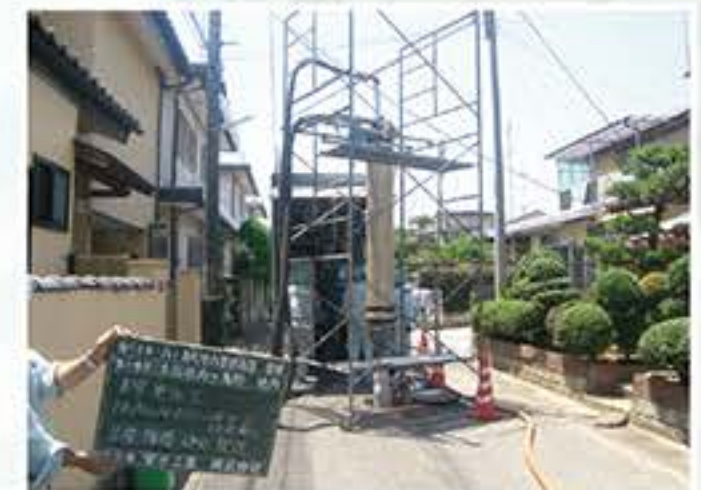
更生材硬化状況
