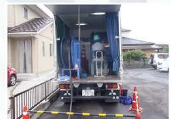
穿孔ロボット操作状況
