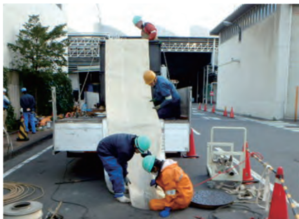
写真-1 施工状況（材料挿入状況）
