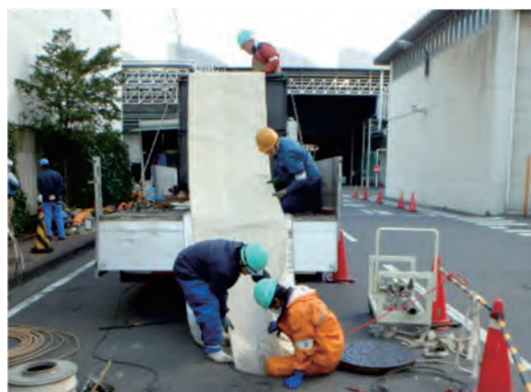
写真-1 形成工法施工状況（材料挿入状況）
