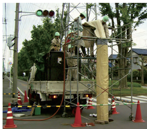
写真-2 反転工法施工状況（材料挿入状況）
